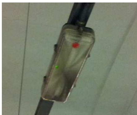
Imagen baliza autónoma de alumbrado de emergencia
